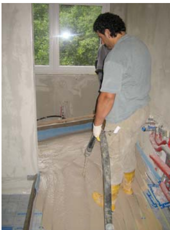
5. Gießen des Estriches
