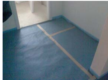
2. Armierungsnetz fertig verlegt
