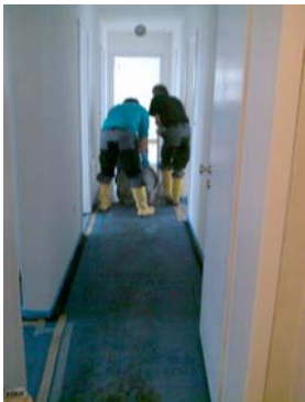
3. Verteilen des Leichtestriches
