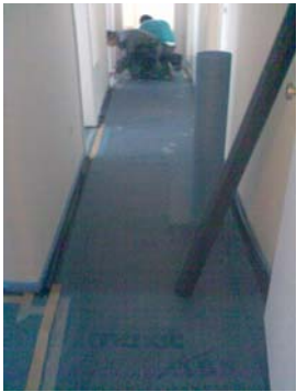
1. Verlegung des Armierungsnetzes
